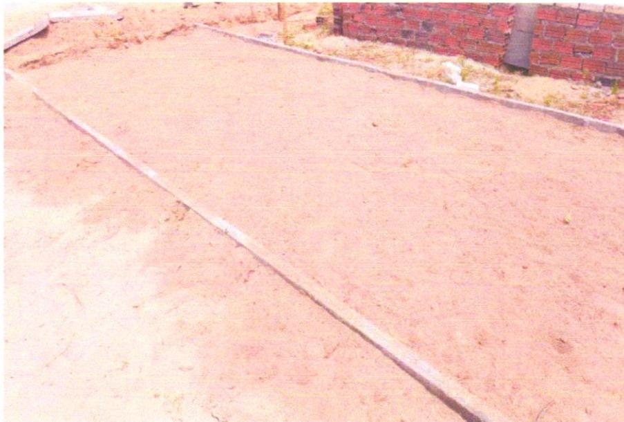
**FOTO 03 - REATERRO MANUAL COM COMPACTAÇÃO MECANIZADA EM CAMADAS DE 0,20 M NO MÁXIMO, COM MATERIAL DA PRÓPRIA OBRA**
