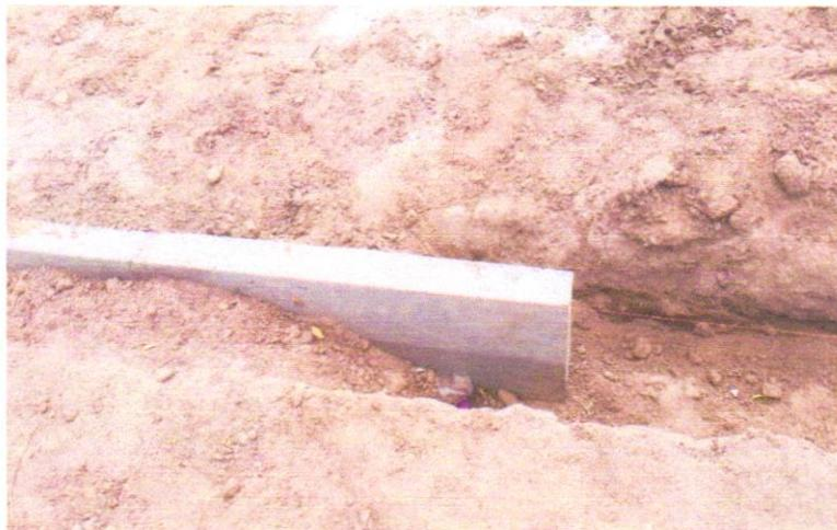
**FOTO 06 – ASSENTAMENTO DE GUIA (MEIO-FIO) EM TRECHO CURVO, CONFECCIONADA EM CONCRETO PRÉ-FABRICADO, DIMENSÕES 100X15X13X20 CM (COMPRIMENTO X BASE INFERIOR X BASE SUPERIOR X ALTURA), PARA URBANIZAÇÃO INTERNA DE EMPREENDIMENTOS. AF\_06/2016\_P**
