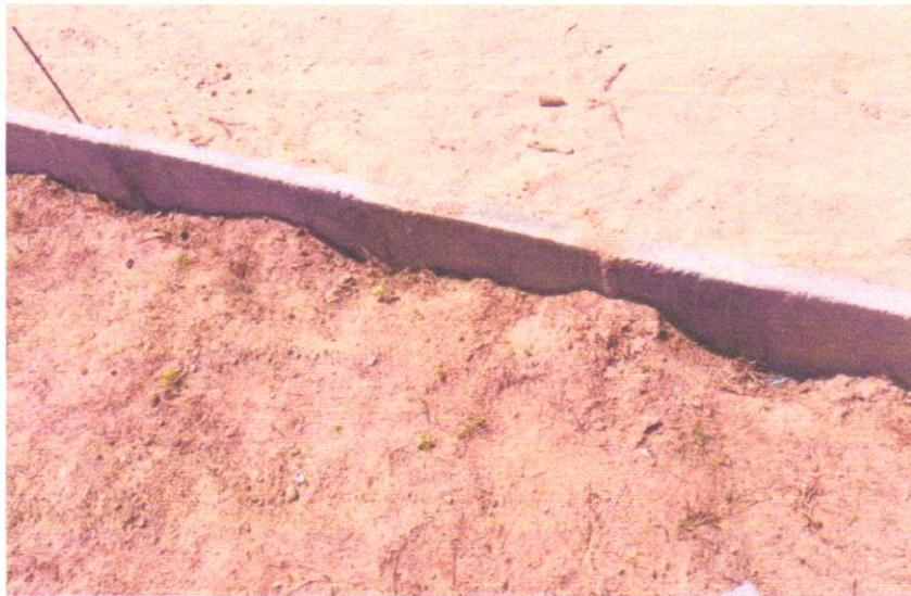
**FOTO 05 – ASSENTAMENTO DE GUIA (MEIO-FIO) EM TRECHO RETO, CONFECCIONADA EM CONCRETO PRÉ-FABRICADO, DIMENSÕES 100X15X13X20 CM (COMPRIMENTO X BASE INFERIOR X BASE SUPERIOR X ALTURA), PARA URBANIZAÇÃO INTERNA DE EMPREENDIMENTOS. AF\_06/2016\_P**
